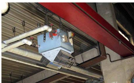
des Heizungskessels, die Nutzung von Kompressorenabwärme aus dem Druckluftbereich sowie der Einsatz einer übergeordneten Gebäudeleitechnik dringend empfohlen. In Kombination mit dem Einsatz von Deckenstrahlplatten im Werkstattbereich anstelle der dort installierten Heizstrahler könnten jährlich voraussichtlich ca. 63.000 l Heizöl entsprechend ca. 32.000 € und fast 200 t CO<sub>2</sub> gespart werden.
